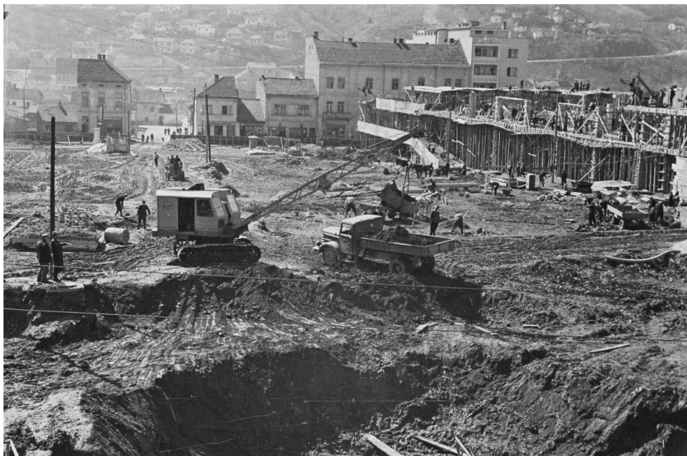
Слика 06. Трг партизана током изградње (1958)
